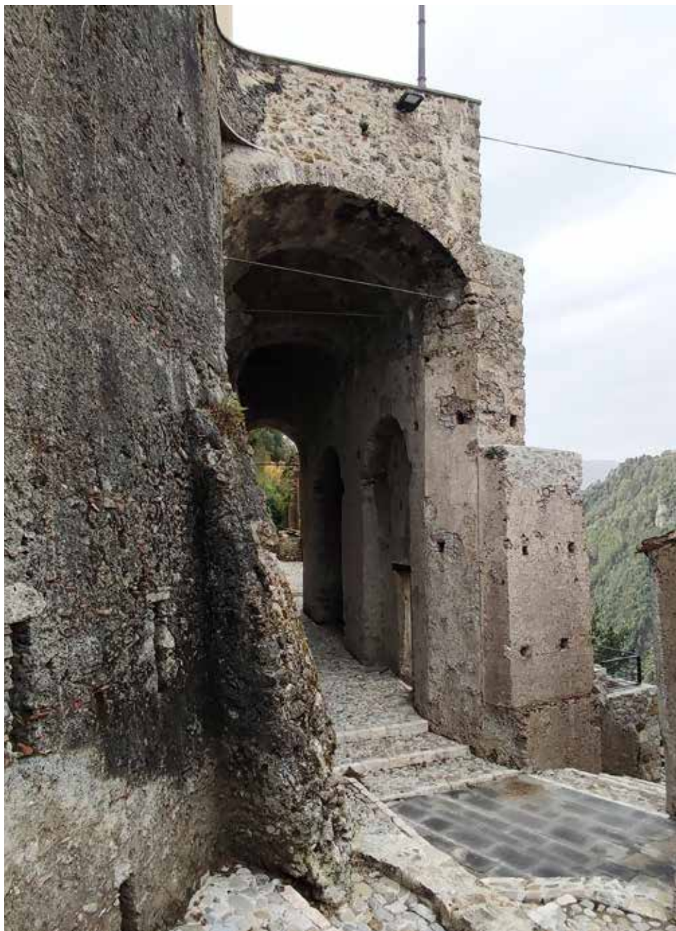
FIG. 37 << Il portico visto dal basso dopo il restauro
