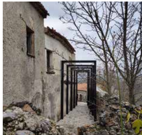
FIG. 50 La "porta" del castello, composta da strutture per la messa in sicurezza.
