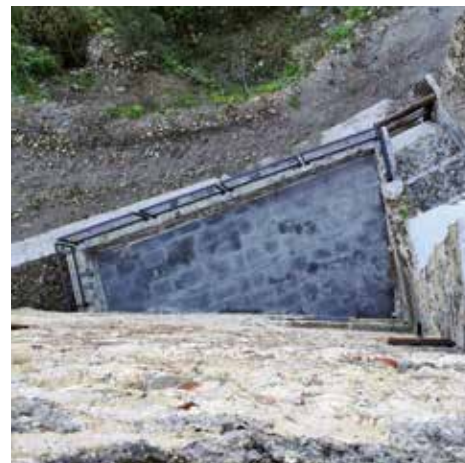
FIG. 46-47 La stanza di un vecchio edificio non più esistente trasformata in terrazza.
