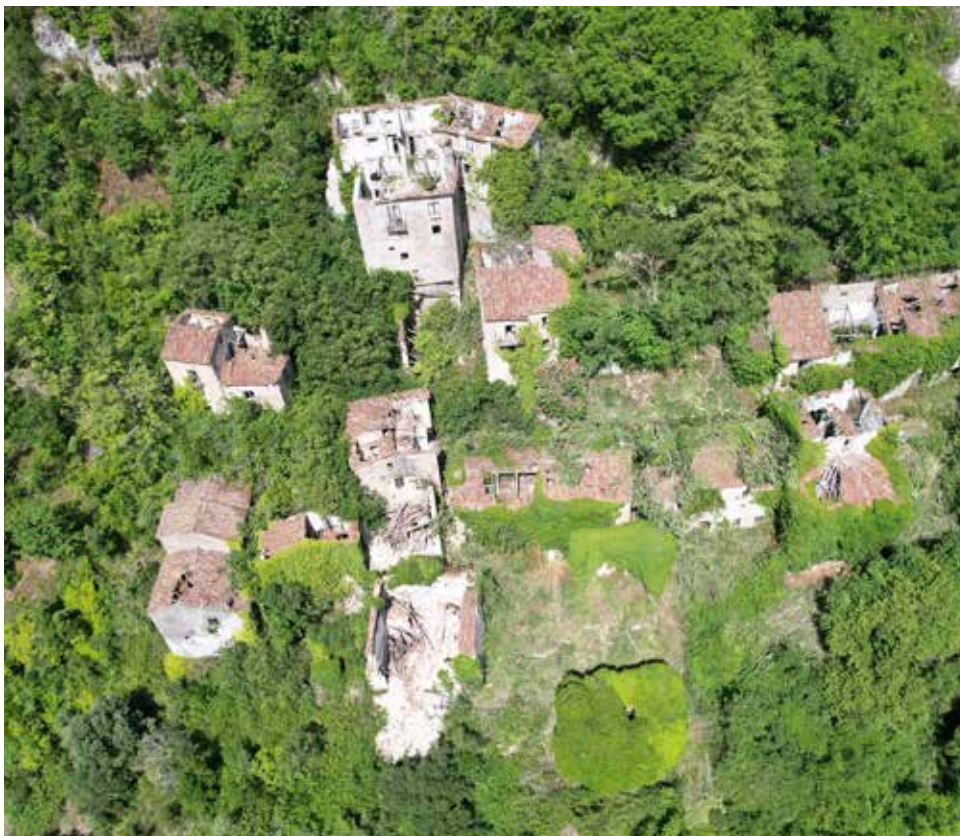
Ampie porzioni del borgo antico risultano inaccessibili e, avvolte dalla vegetazione spontanea, iniziano ad essere parte del bosco autoctono. I crolli cancellano le tracce del passato mentre la natura prende il sopravvento sull'opera dell'uomo.
