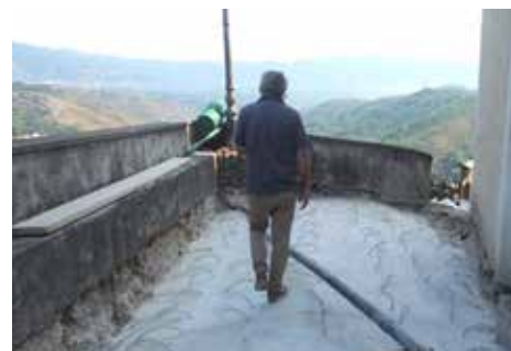
FIG. 45 Intervento di miglioramento strutturale con inserimento di fibrorinforzati nell'estradosso della volta.
