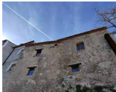
FIG. 53 L'edificio su cui si è stato installato il cavidotto in lamelle di corten. Si osservi l'approccio adottato per il trattamento della facciata: le tracce di intonaco preesistenti sulla sinistra sono state consolidate, sul lato destro si è optato per una leggera scialbatura della superficie (sui muri su cui non era mai stato realizzato un intonaco si è esclusa l'ipotesi di applicare uno strato vero e proprio di intonaco). Inoltre gli architravi in legno sono stati sostituiti e si sono attuate operazioni di rincoccatura del muro e di restauro della cornice a romanella del tetto.
