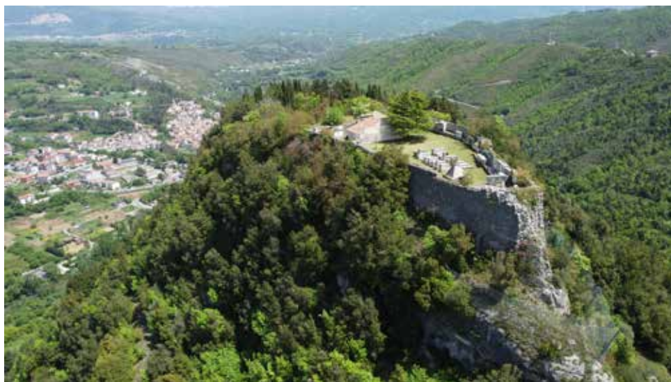
FIG. 1 Castello di Laino, panoramica aerea da sud.
